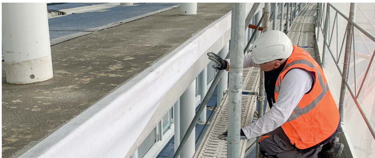
Einbettung des Verstärkungsvlies in Flüssigkunststoff.
